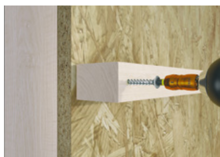
Fixation d'un niveau d'installation
