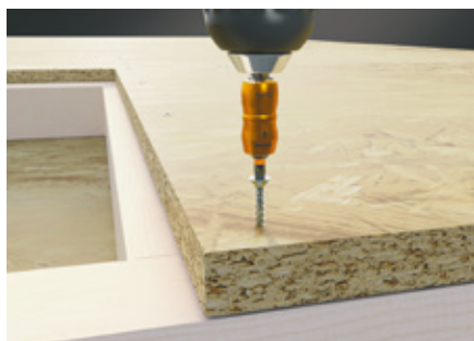
Pose de panneaux OSB
