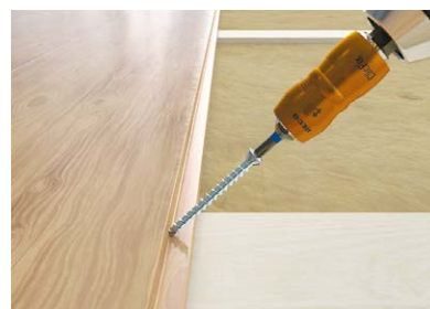
Vastzetten van vloerplanken
