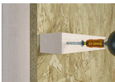
Bevestiging van regelwerk t.b.v. installaties
