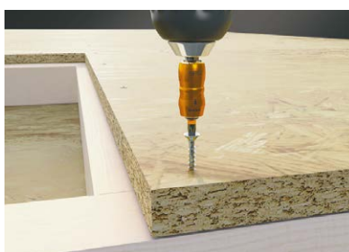
Pose de panneaux OSB
