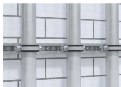
Fixation des installations d'eau
