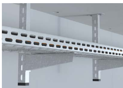
Bevestiging van kabelschachten
