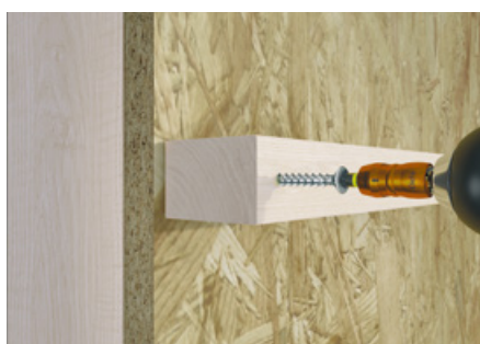
Bevestiging van regelwerk t.b.v. installaties
