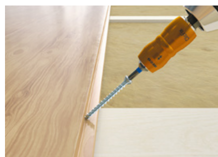
Vastzetten van vloerplanken
