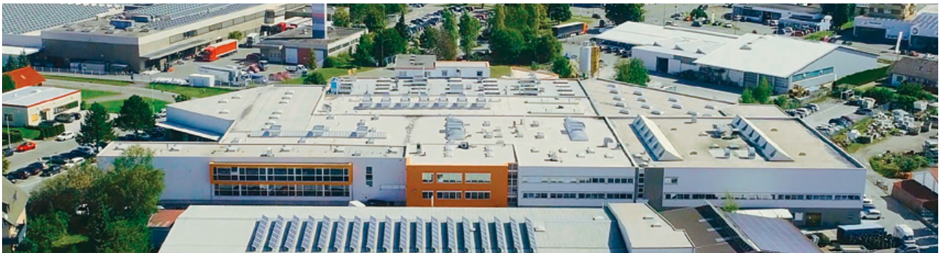
Het hoofdkantoor en fabriek in Schramberg-Sulgen
