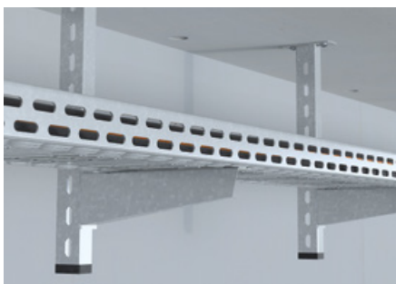
Bevestiging van kabelschachten
