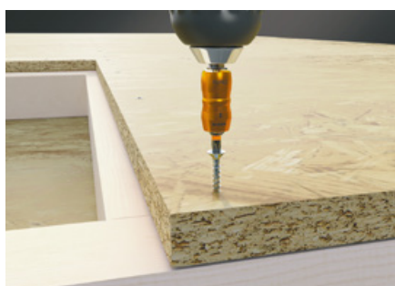
Pose de panneaux OSB
