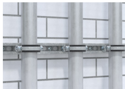
Fixation des installations d'eau
